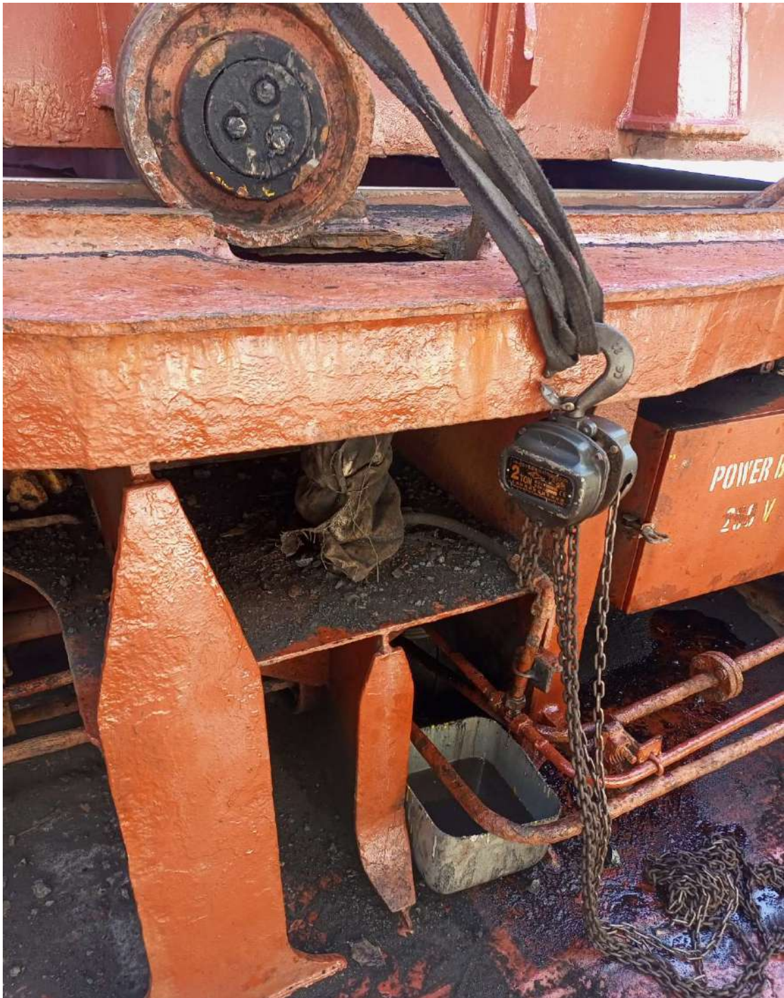
Lampiran 17 Dislokasi pada roda hatch cover
