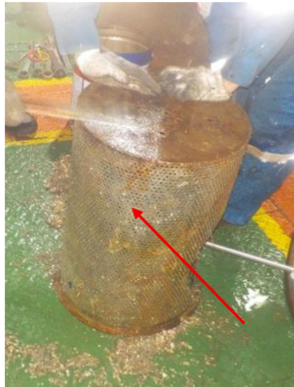
Gambar 1. 2 Pembersihan Filter Sea Chest (Sumber: Dokumentasi Pribadi)
