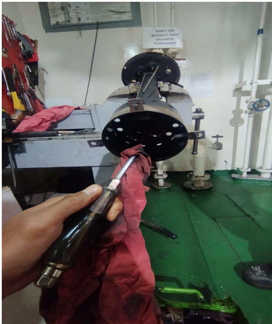
Main Burner setelah dibersihkan
