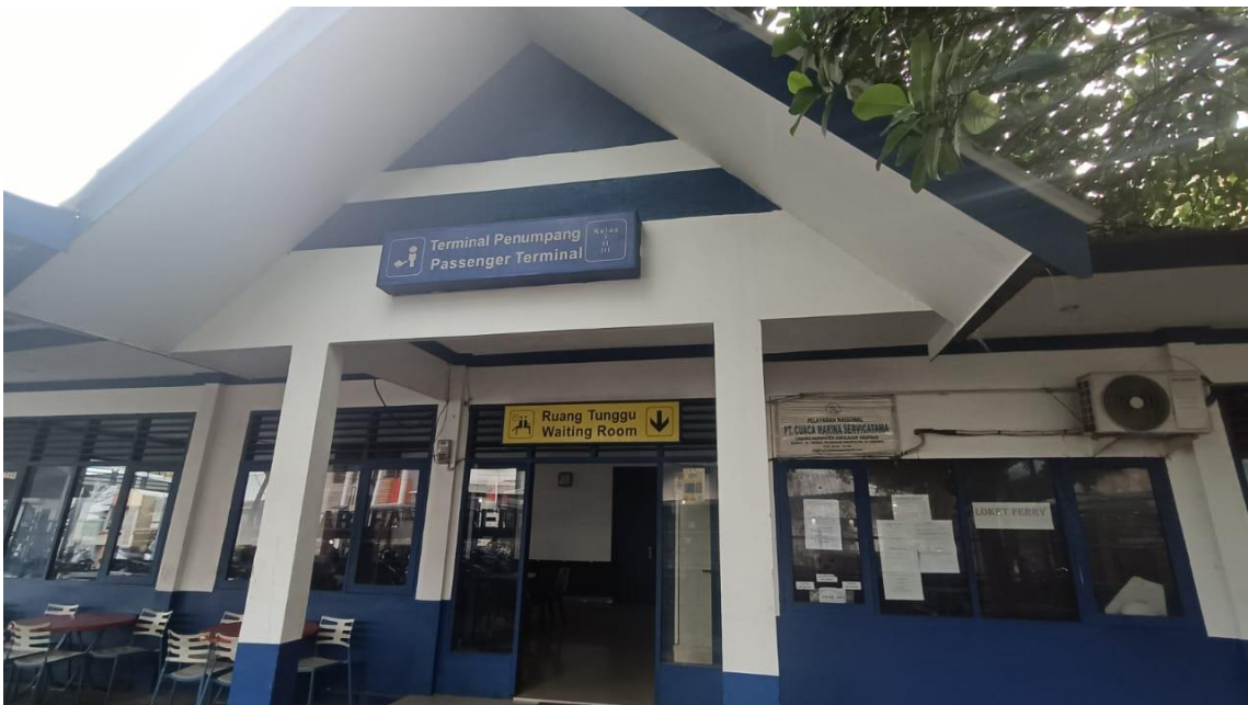
Foto Lampiran 19.2 Terminal Penumpang
